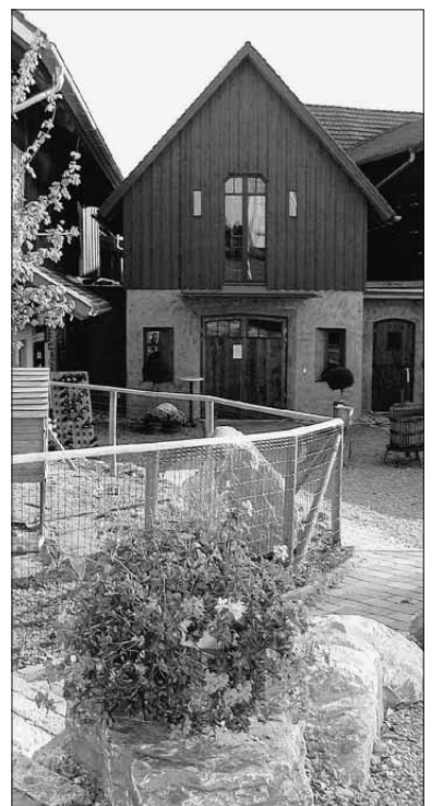
Zwischen den beiden bestehenden Gebäuden fand der Anbau des Weinstadls Rimmele Platz. Im Zugangsbereich wurde auch ein Hasengehege (links) angelegt.
